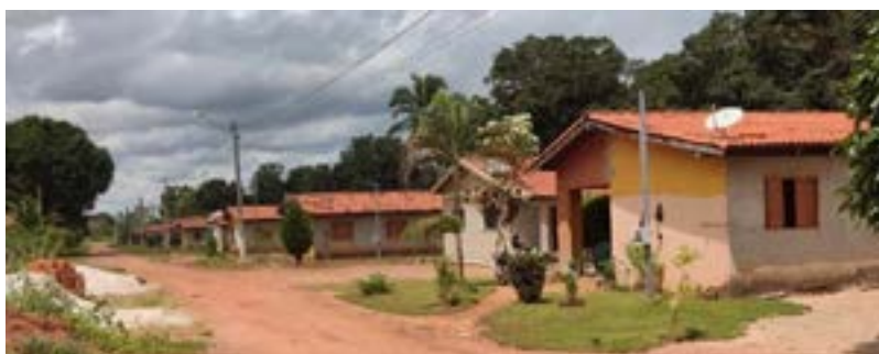
Figura 3. Casas construídas por meio programa habitacional no quilombo Cocalinho
