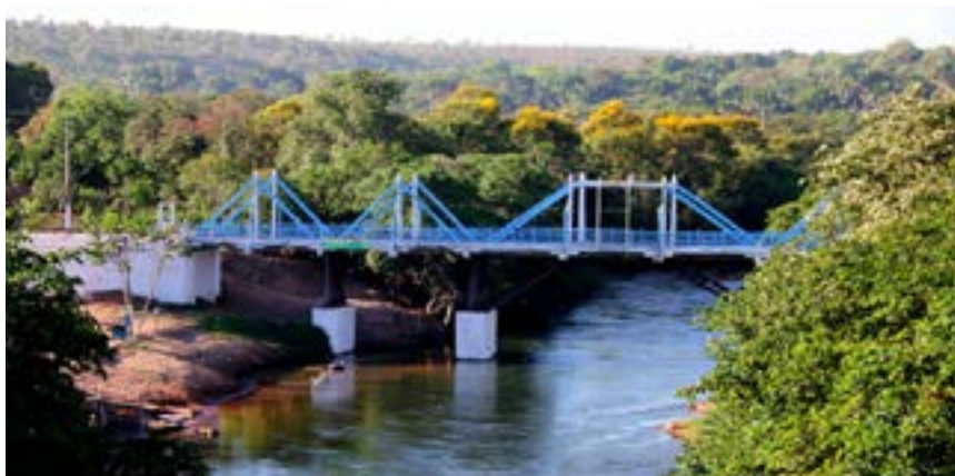
Figura 34. Principal ponte em Ponte Alta do Tocantins – TO
