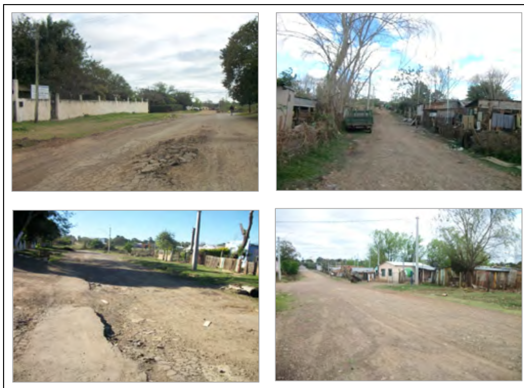
Figura 8. Condições dos arruamentos nos bairros de Uruguaiana atingidos por inundações.
