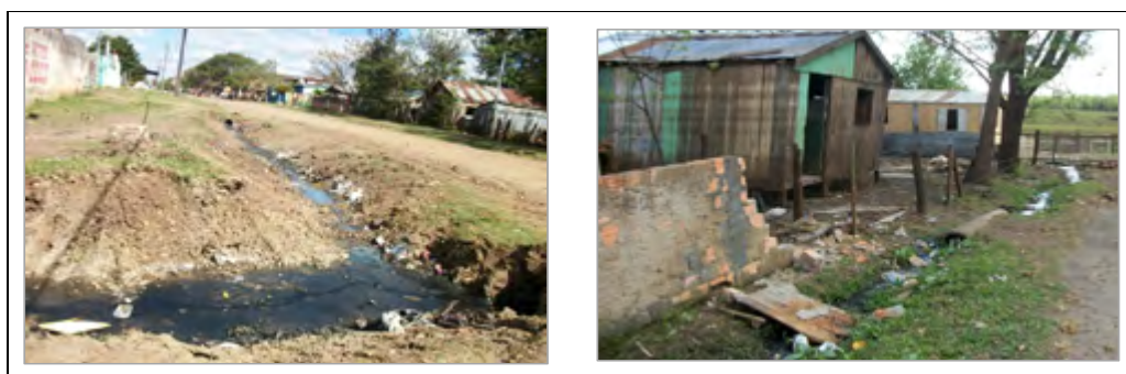
Figura 10. Esgoto lançado diretamente em drenagem superficial de água. Bairro Mascarenhas de Moraes.
