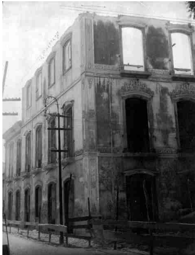
Figura 1. Demolição do casarão do Comendador (1946)
