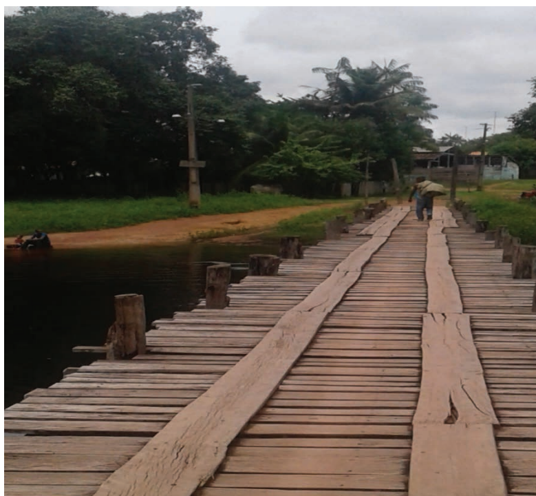
Imagem 1 – Ponte de acesso à comunidade
