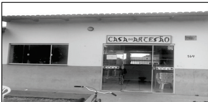
Figura 4 – Sede da Casa do Artesão
