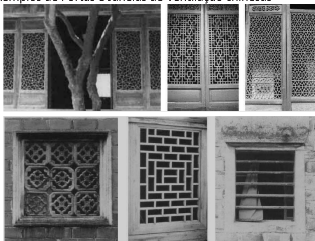
Figura 2. Exemplos de Portas e Janelas de Ventilação chinesas
