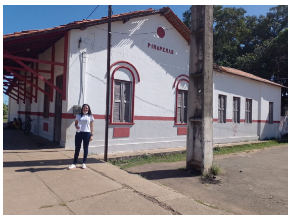
Figura 4. Estação Ferroviária de Pirapemas/MA
