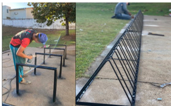
Figura 3. Pátio do colégio durante a construção do bicicletário
