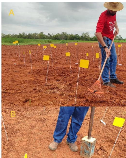
Figura 4. Rastelo e o implemento para compactação.
